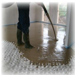
Économique et performante, la chape fluide permet de réaliser des sols parfaitement plats. Elle permet la réalisation de chapes autonivelantes et autolissantes, de chapes flottantes ou désolidarisées.
